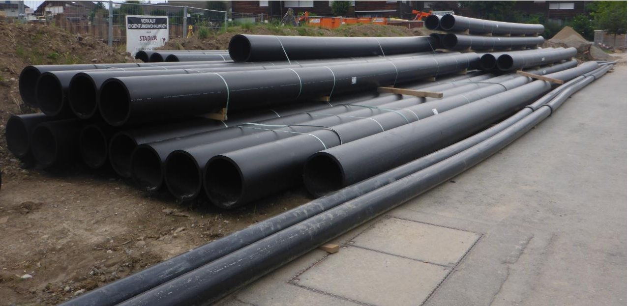
GEROthern® Rohre fachgerecht auf der Baustelle gelagert
