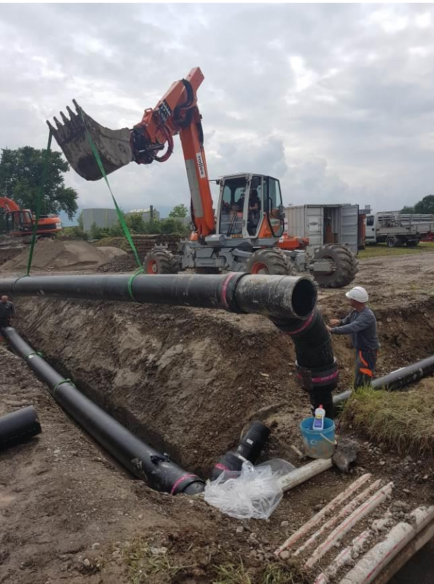
Einfache Verlegung der Rohre in den Graben
